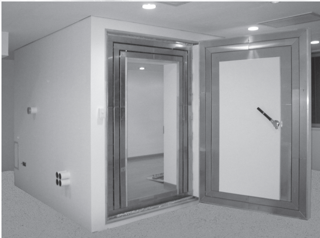
設置例 (内寸: W2000×D3600×H2000mm)
